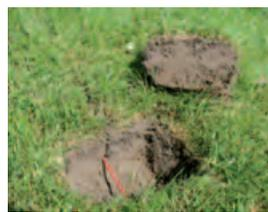
La lama con speciale profilo, taglia meticolosamente ogni zolla e filo d'erba senza provocare inestetismi e danni visibili della superficie erbosa. Il cavo è steso nel terreno tramite un condotto interno alla lama e interrato alla profondità di circa 5 cm. A questa profondità, il cavo è al sicuro da possibili contatti e rotture provocati da successive lavorazioni del terreno come, ad esempio, l'arieggiatura o la risemina.
